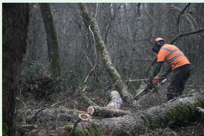
Réalisation de travaux favorables à la connectivité des forêts
